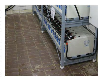
Obwohl der Raum mit Elektrolyten erheblich kontaminiert ist, zeigen die BACS-Module auch nach über 15 Jahren dort im Einsatz keinerlei Korrosionsschäden!
